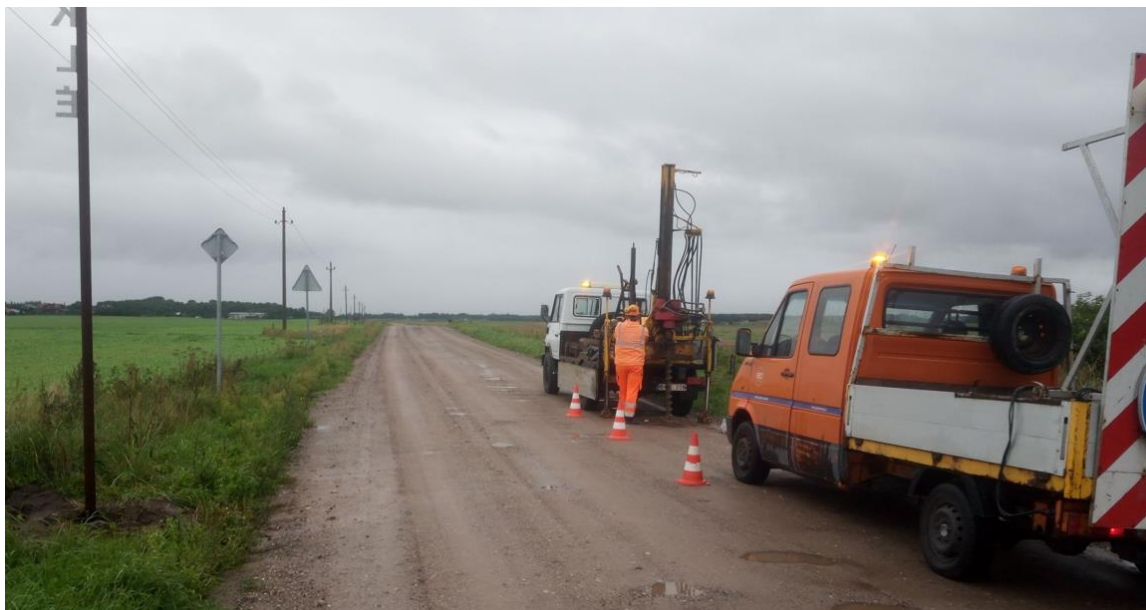
1 pav. Lauko darbai
